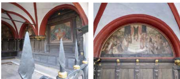
Nord-Ost-Ecke Lüneburger Rathaus – hier befand sich früher das Niedergericht
